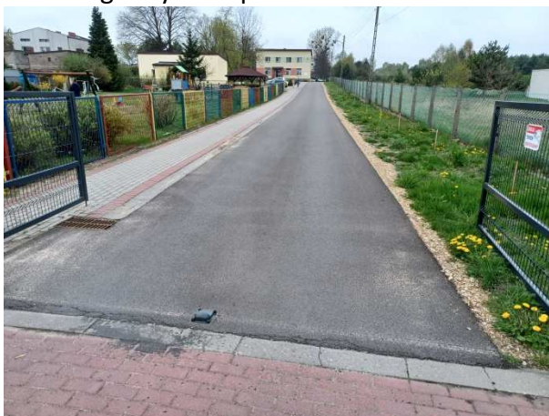
Fot. 1. Droga dojazdowa do Szkoły Podstawowej w Łażcu
