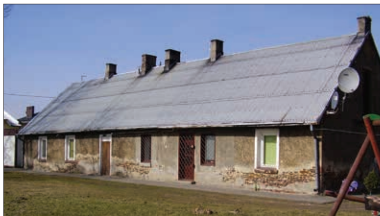
Fot. 5: Pierwszy budynek kolonijny – ściana południowa, gdzie po jego zbudowaniu, było zadaszenie nad letnią jadalnią, widok z 2017 roku.
