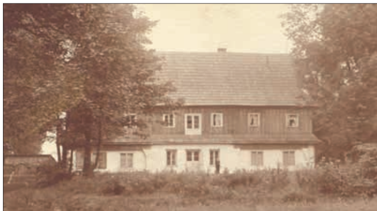
Fot. 26: Wygląd dworku przed 1939 rokiem, po rozebra- niu balkonu. Widoczny jest jeszcze dach dwuskładowy kryty gontami.
