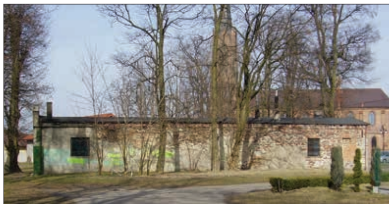
Fot. 29: Dawna stajnia dworska, ściana południowa, widok z 2017 roku.
