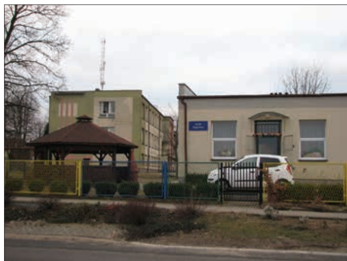
Fot. 60: Kopalnia, na pierwszym planie stara szkoła po przebudowie, w głębi nowa szkoła.
