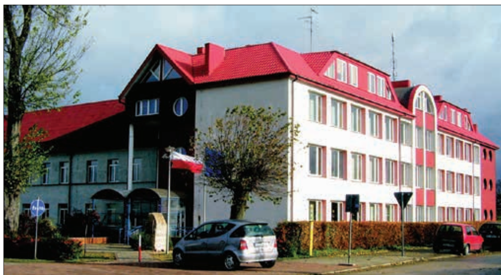
Fot. 4: Gimnazjum z wejściem głównym od strony ulicy Sportowej, z lewej strony widoczna część starej szkoły połączonej z Gimnazjum, przed wejściem widoczny obelisk poświęcony patronowi szkoły.
