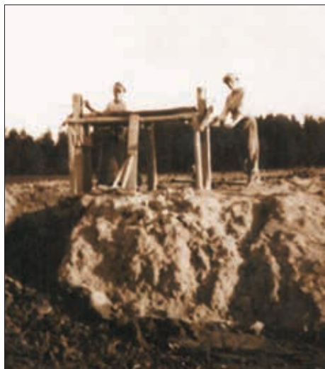
Fot. 105: Kopalnia szybikowa w Łączu z ręcznym kołowrotem, 08.08.1938 r.
