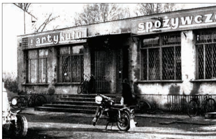
Fot. 86: Sklep Gminnej Spółdzielni SCh w Konopiskach, lata 70.
