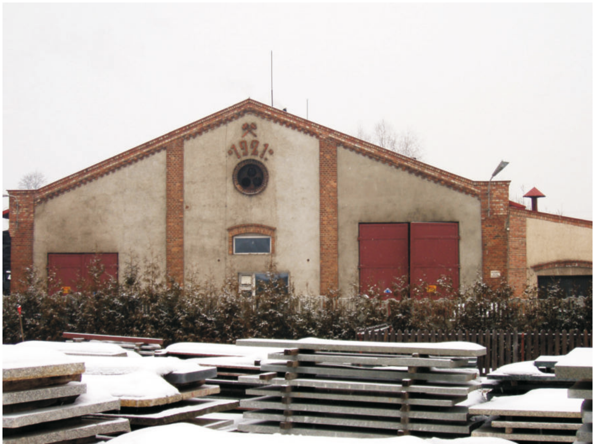
Pierwsza parowozownia kopalni „Konopiska”. Po przebudowie wnętrza w 1927 r. uruchomiono w niej płuczkę rudy. Obok usytuowano rozległe zbiorniki wodne. Obecnie jest tam prywatna Kuźnia
