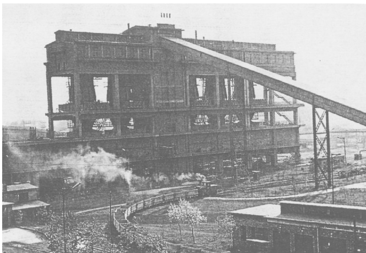
Piece prażalnicze w Sabinowie - część centralnego kompleksu urządzeń przygotowujących rudę do wytopu (płuczka, kruszarnia, piece). Powstały na bazie doświadczeń pracy takich urządzeń w Konopiskach i Dźbowie. Zdjęcie z lat 60-tych XX wieku
