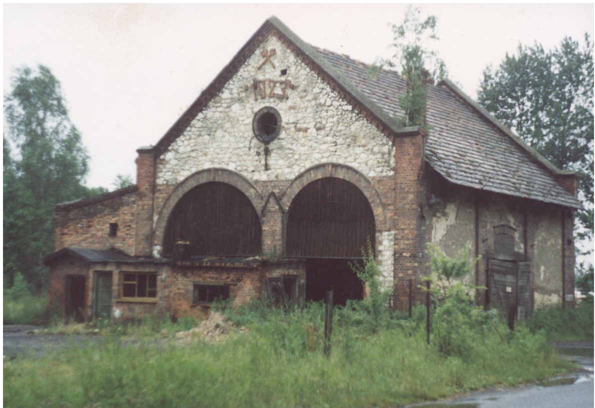
Parowozownia z 1923 r. Po II wojnie światowej przerobiona na remizę Zawodowej Straży Pożarnej Rejon Konopiska. Po likwidacji kopalń budynek użytkowała Gminna Spółdzielnia „Samopomoc Chłopska” w Konopiskach. Po roku 2000 została wyburzona
