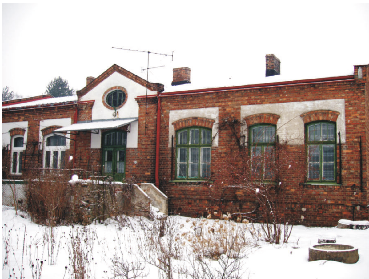
Jeden z dwóch budynków mieszkalnych zbudowanych w ogrodzie dyrektorskim dla urzędników kopalni
