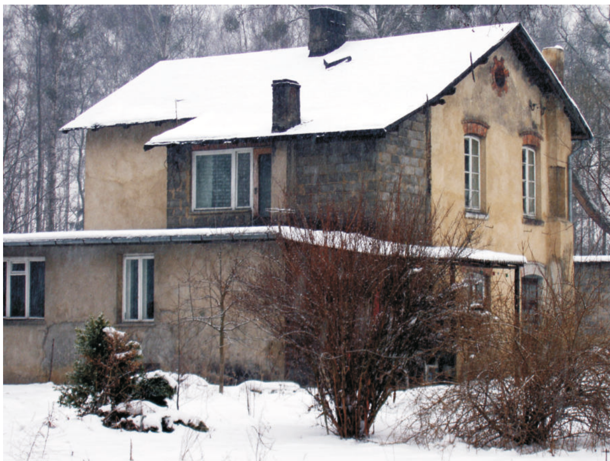
Pozostałość stajni dla koni dyrektora kopalni. Po przebudowach budynek mieszkalny
